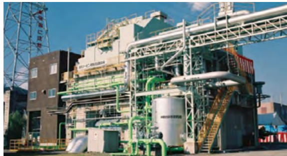
Actual Loading Test Facility
